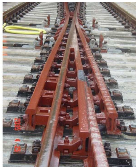
Obrázek 38: /DE/: Odlévané pohyblivé hroty srdcovek s přerušenou hrotovou kolejnicí v odbočné větvi (zdroj [13]).
