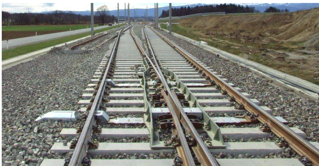
Obrázek 37: /AT/: Srdcovka s pohyblivým hrotem na trati Koralmbahn (zdroj: ÖBB).
