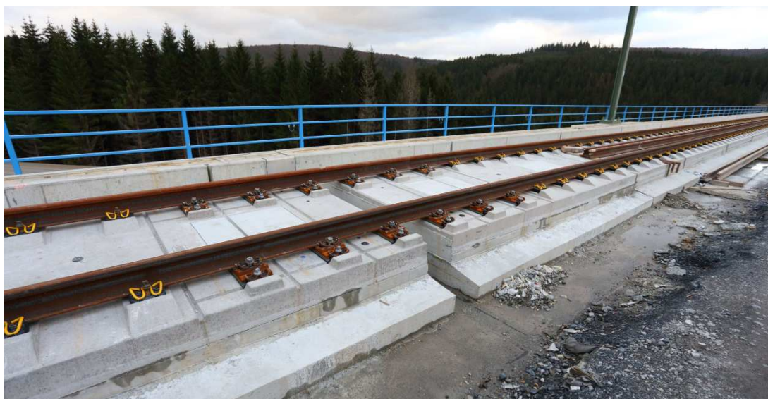
Obrázek 30: /DE/: Úprava PJD nad mostním závěrem u pevného ložiska se speciálními upevňovacími.
