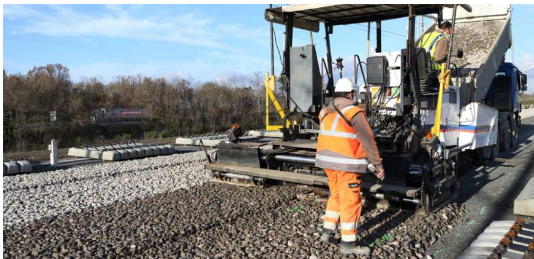
Obrázek 20: Strojní předštěrkování na trati LGV SEA ve /FR/ (zdroj: LISEA).
