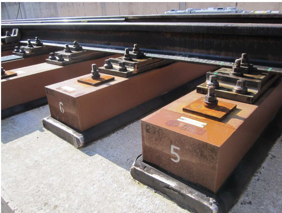
Obrázek 46: Detail uložení syntetického pražce na betonové desce (Zdroj: Web Around the KANAZAWA STATION).
