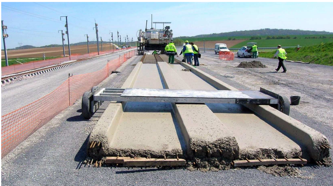
Obrázek 31: /FR/ : Zkušební úsek s PJD na trati LGV Est européenne u obce Meaux (zdroj: SNCF).
