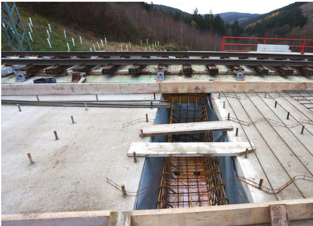
Obrázek 72: /DE/: Armování koncové zídky na budoucím styku PJD mezi zemním tělesem a mostem na trati NBS Ebensfeld – Erfurt.
