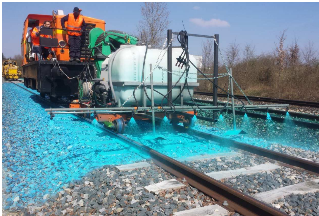
Obrázek 23: /FR/: Provádění postřiku materiálem Aqua-Rail (zdroj: Colas).
