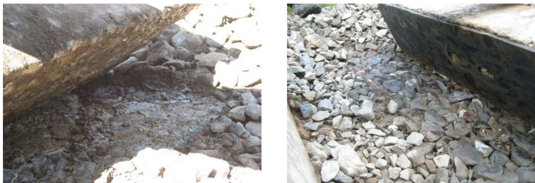
Obrázek 16: Rozdíl ve stavu kolejového lože po 10 letech provozu při ročním zatížení 10 mil. tun; vlevo bez USP; vpravo s USP (zdroj: ÖBB).
