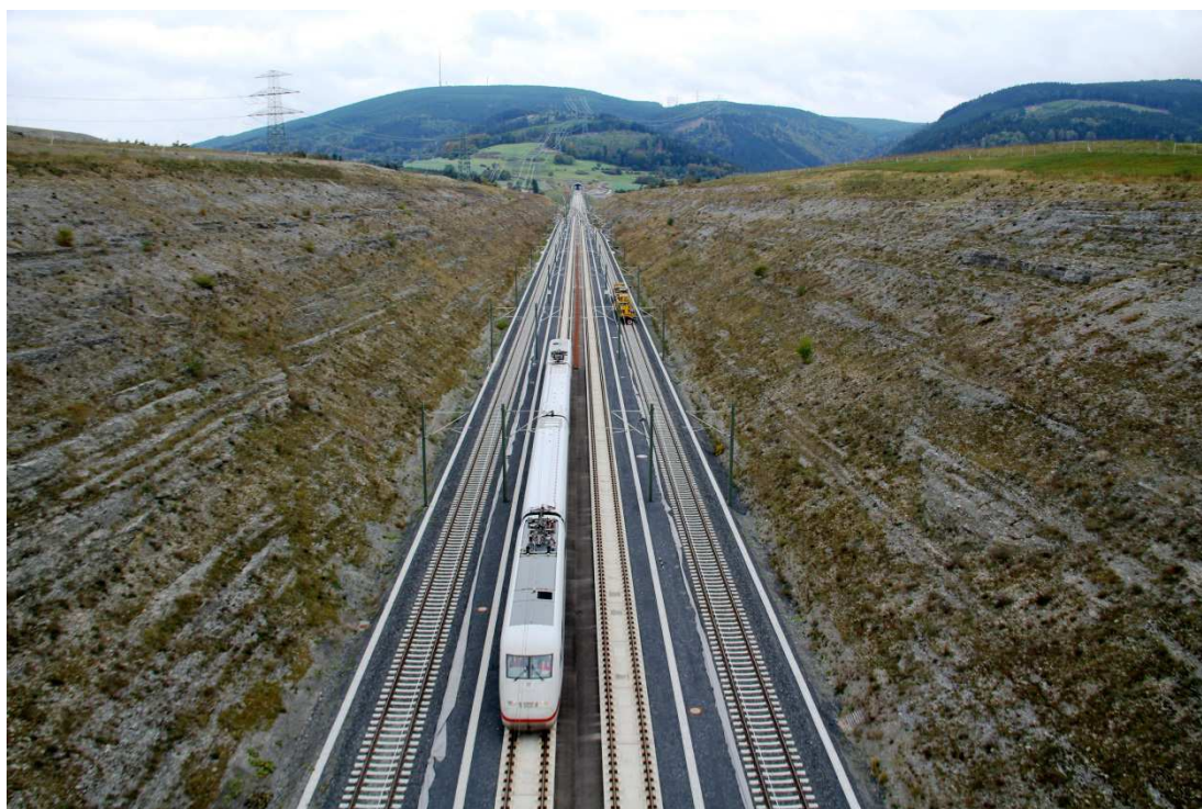
Obrázek 71: /DE/: Zářez ve skalních horninách na trati Ebensfeld – Erfurt ve výhybně Theuern (zdroj: Hannes Frank, DB).
