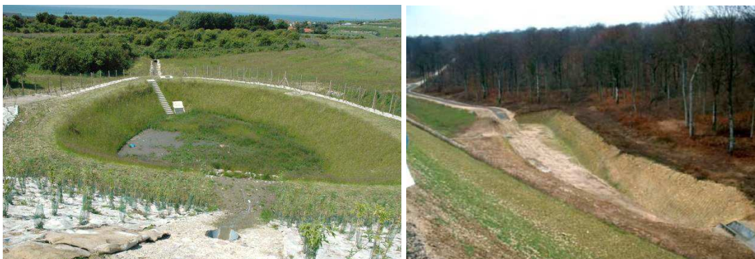
Obrázek 98: /FR/: Příklady retenčních nádrží (zdroj vlevo: Le Bloc de Frédéric Cuvillier; zdroj vpravo: SNCF)
