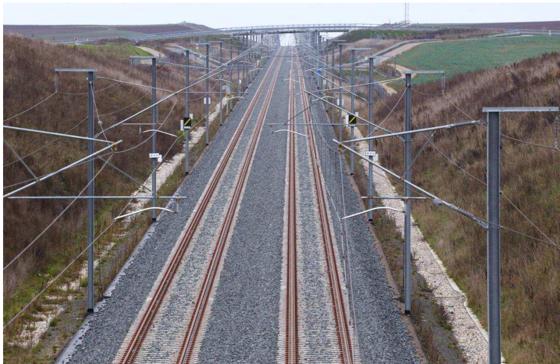
Obrázek 97: /FR/: Zářez na trati LGV Est européenne s asfaltobetonovou konstrukční vrstvou odvodněný trativody.
