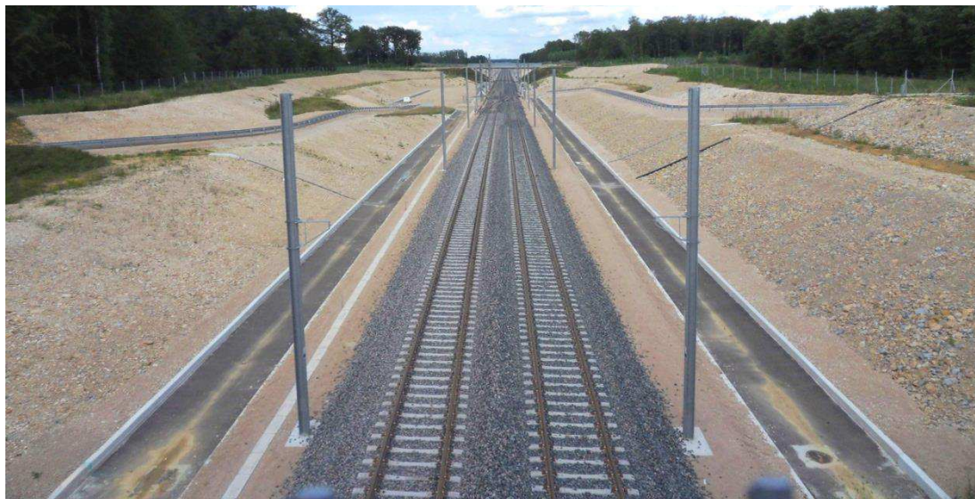
Obrázek 94: /FR/: Zářez na trati LGV Rhin-Rhône odvodněný kombinací trativodu a poježděné kynety s obrubníky (foto G CHP, dostupné z URL https://commons.wikimedia.org/wiki/File:LGV_Rhin-Rh%C3%B4ne_bifurcation_de_Villers-les-Pots4.JPG ; CC-BY-SA 2.5)
