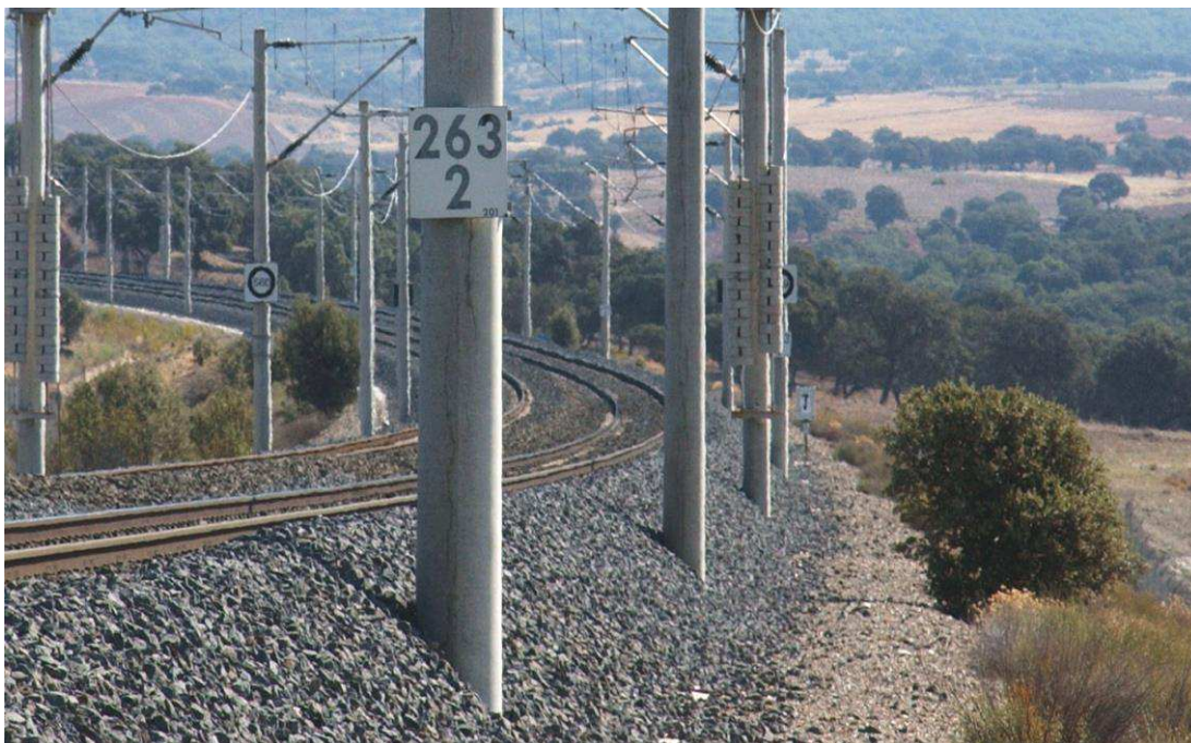
Obrázek 84: /ES/: Kolejové lože dosypané po poklesu zemního tělesa na trati Madrid - Sevilla (zdroj: [65]).
