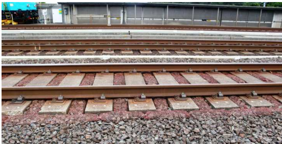
Obrázek 26: Plastové síť na povrchu kolejového lože v Japonsku (zdroj [37]).
