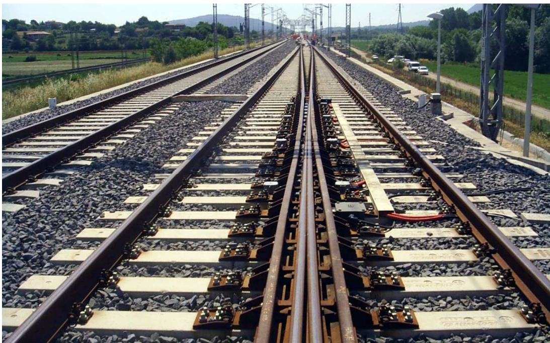
Obrázek 42: /IT/: Srdcovky výhybky pro rychlost 160 km/h (zdroj: Italferr).
