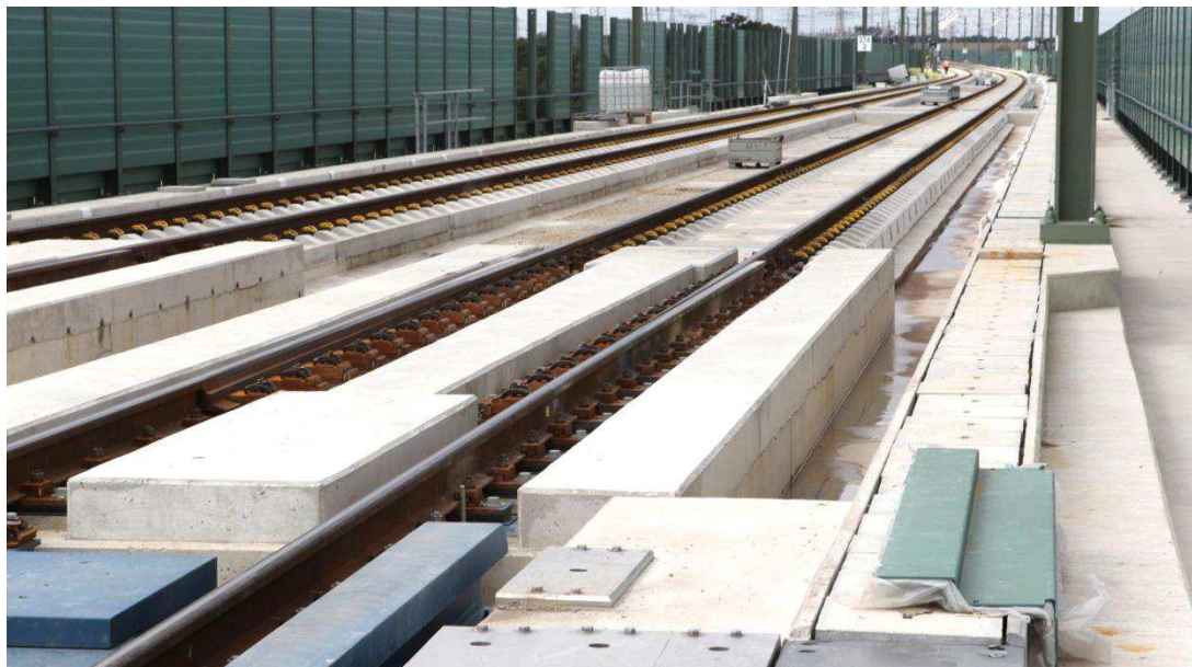
Obrázek 53: /DE/: Přečtová konstrukce a KDZ nad pilířem mostu Saale-Elster-Talbrücke v úseku Erfurt – Leipzig/Halle zprovozněném v roce 2015 (foto Claus Rudolf, dostupné z URL
