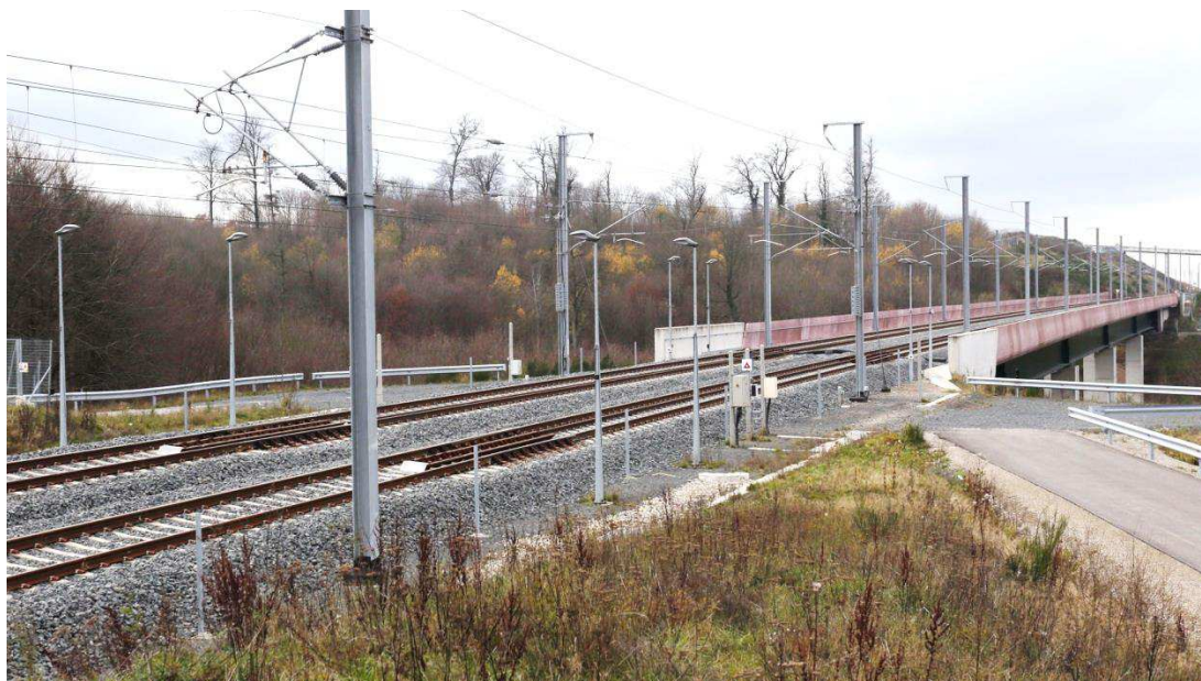
Obrázek 54: /FR/: Uspořádání KDZ za opěrou mostu (Viaduc de Haspelbaechel) na trati LGV Est européenne Paříž – Strasbourg zprovozněné v roce 2016.
