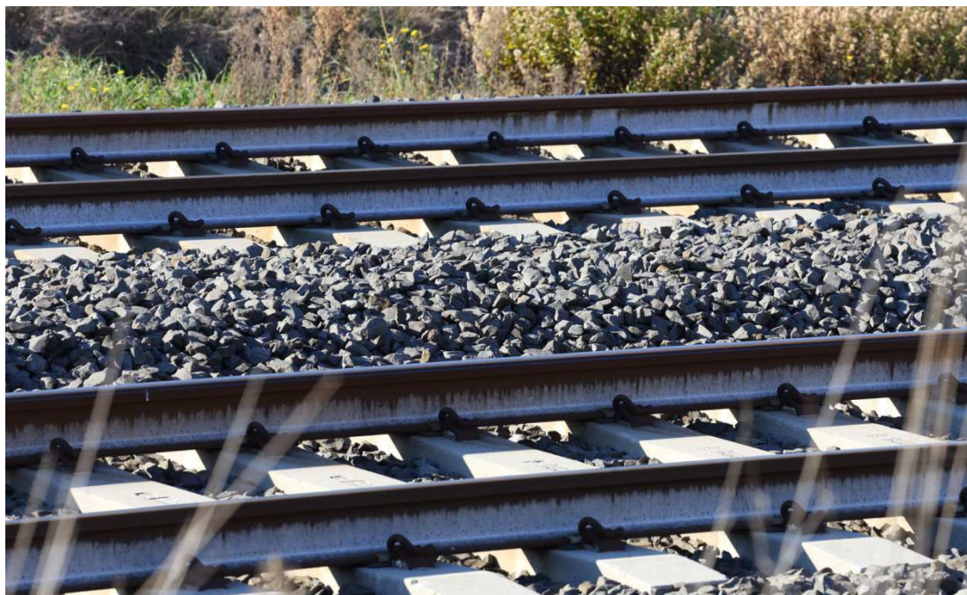
Obrázek 25: Snížený povrch kolejové lože v /IT/.
