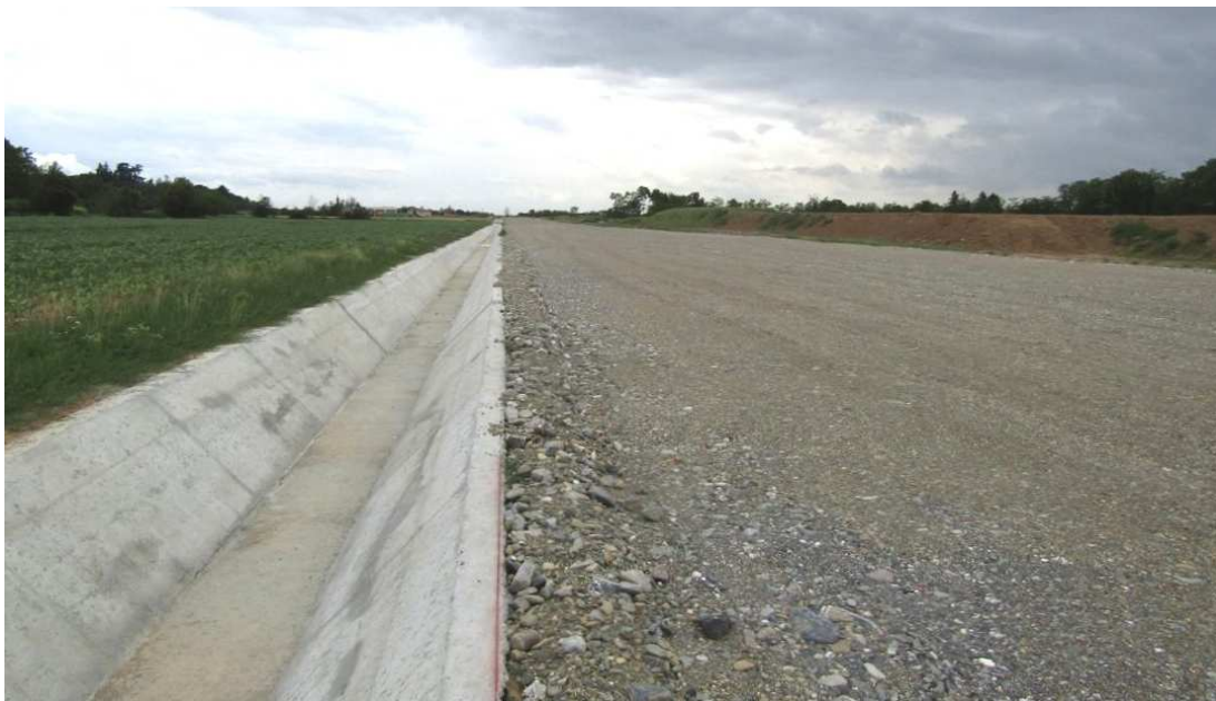
Obrázek 102: /IT/: Monolitický na místě zhotovený příkop u paty budovaného náspu na trati Terzo Valico (zdroj: COCIV).
