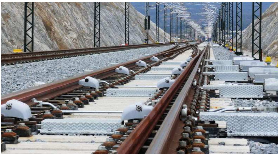
Obrázek 52: /ES/: Výhybka DSIH-AV-UIC60-17000/7300-1:50 pro rychlost 220 km/h v odbočné větvi s elektromotorickými přestavníky pro každý závěr (zdroj: Alberto Salviejo).
