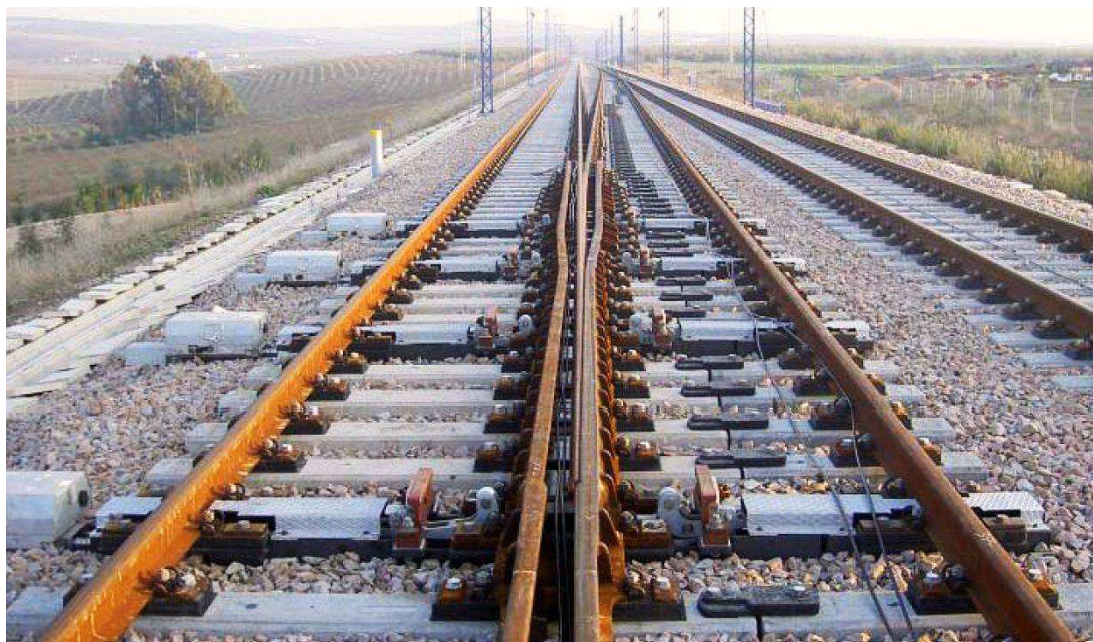
Obrázek 41: /ES/: Monolitický blok srdcovky pro výhybku s rychlostí 220 km/h v odbočném směru (zdroj: ADIF).
