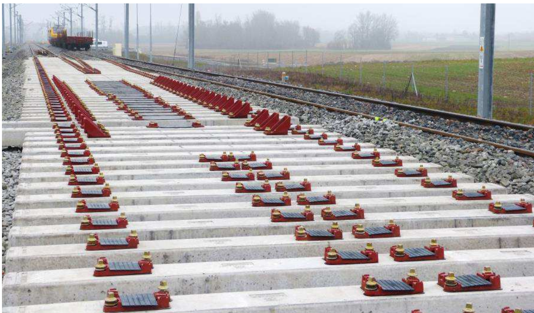
Obrázek 34: /FR/: Podkladnice tvořící úklon 1:20 na trati LGV Tours – Bordeaux (Zdroj:LISEA).
