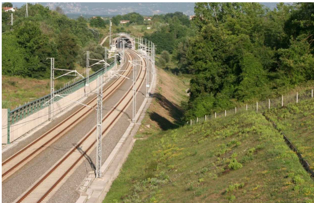
Obrázek 104: /IT/: Zářez odvodněný malým příkopovým žlabem u paty a ve svahové lavičce (zdroj: Collegio Ingegneri Ferroviari Italiani).
