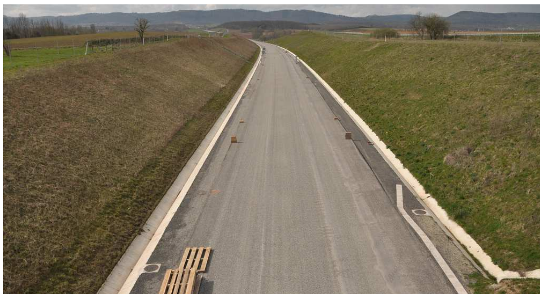
Obrázek 95: /FR/: Pláň tělesa trati LGV Est européenne odvodněná kombinací trativodů a kynet či příkopů tvaru „V“. Kabelové trasy jsou převážně délce trati vedeny ve výkopech místo pochozích kabelových žlabů (zdroj: http://www.trainsfrancais.com/ ).
