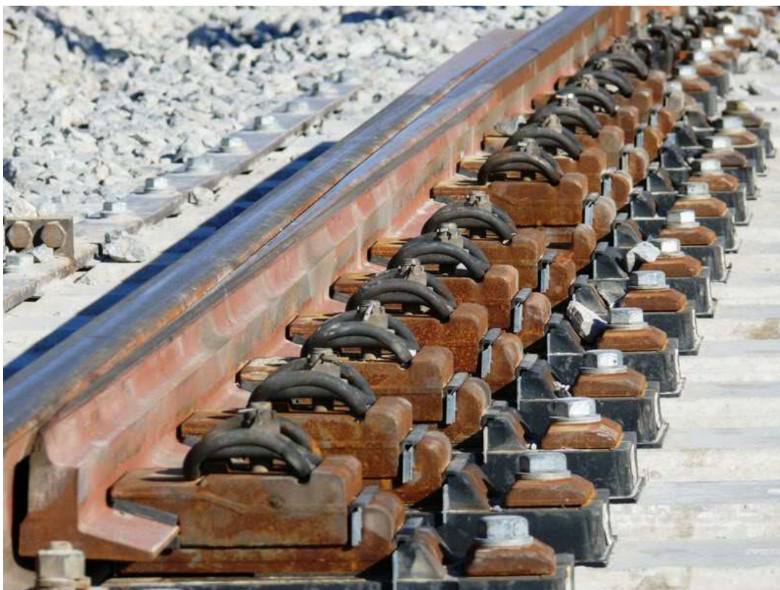
Obrázek 58: /ES/: Detail upevnění jazykové kolejnice KDZ (foto Alberto Salviejo).
