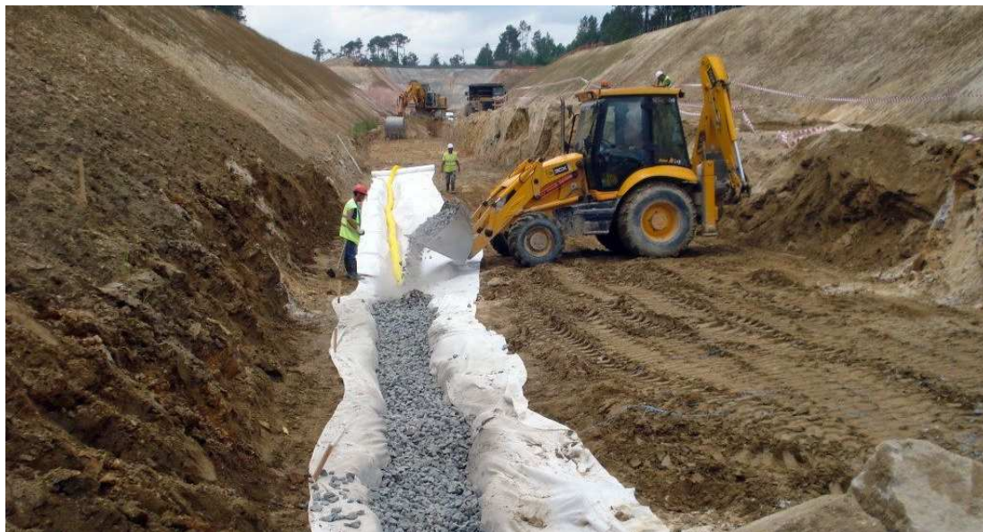
Obrázek 101: /ES/: Zřizování trativodu v zářezu (zdroj: [61]).
