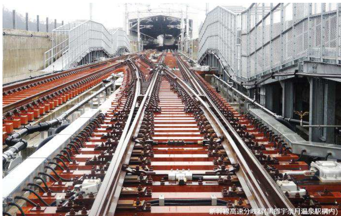
Obrázek 45: Výhybka na syntetických pražcích v Japonsku (Zdroj: DAITETSU KOGYO CO.,LTD., JR GROUP)
