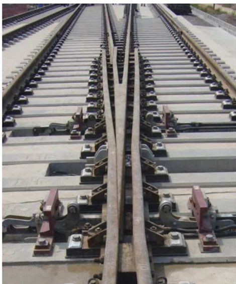
Obrázek 38: /DE/: Odlévané pohyblivé hroty srdcovek s přerušenou hrotovou kolejnicí v odbočné větvi (zdroj [13]).
