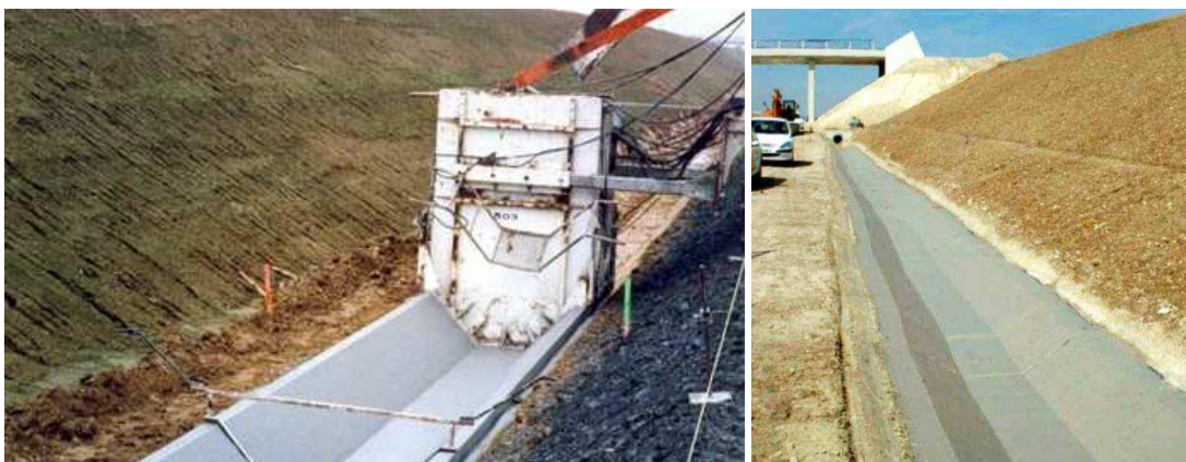
Obrázek 93: /FR/ : Realizace monolitického zpevněného příkopu (zdroj vlevo: Planete TP; zdroj vpravo: SNCF).
