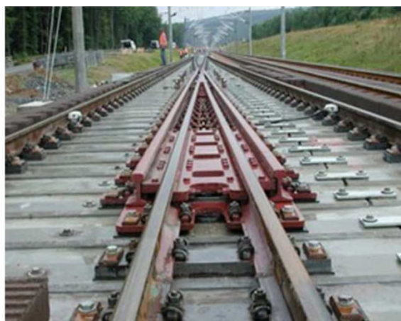
Obrázek 39: /DE/: Odlévané hroty srdcovek s nepřerušenými hrotovými kolejnicemi (zdroj [13]).
