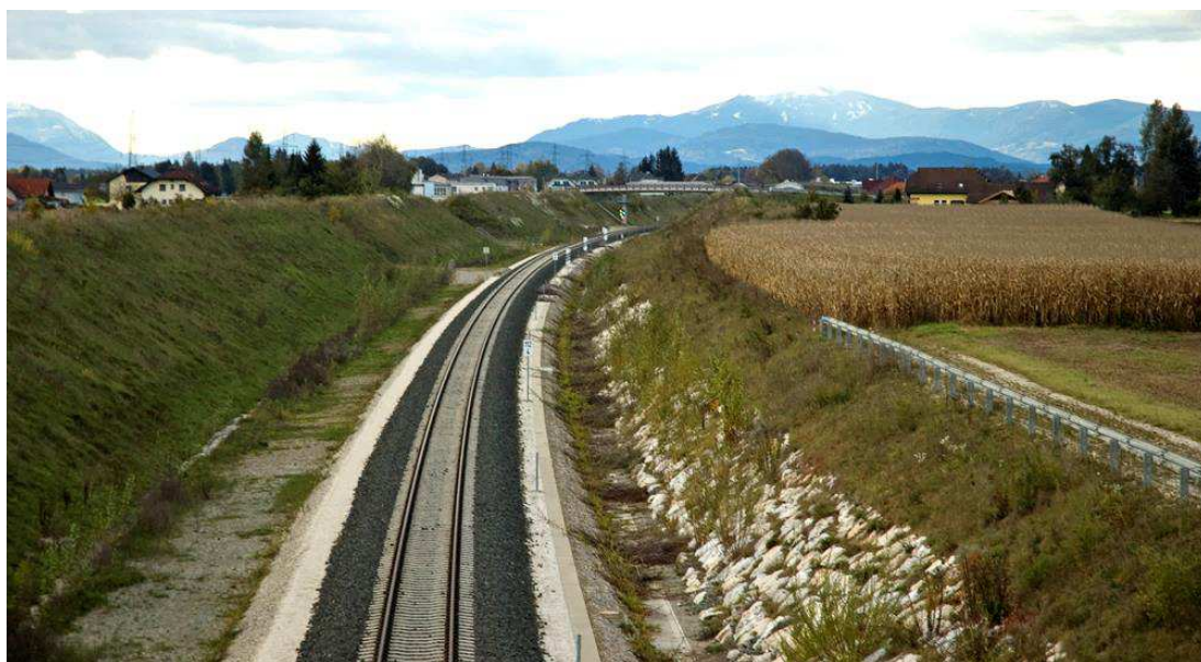
Obrázek 90: /AT/: Zářez na trati Koralmbahn odvodněný nezpevněnými příkopy a trativodem (u již položené koleje; zdroj: www.styria-mobile.at ).
