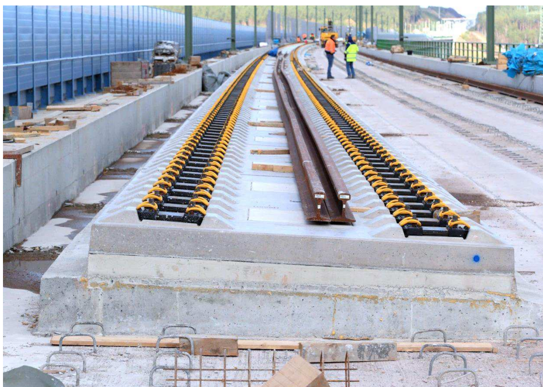
Obrázek 28: /DE/: Konstrukce PJD ÖBB-Porr na mostě na trati NBS Ebensfeld – Erfurt .
