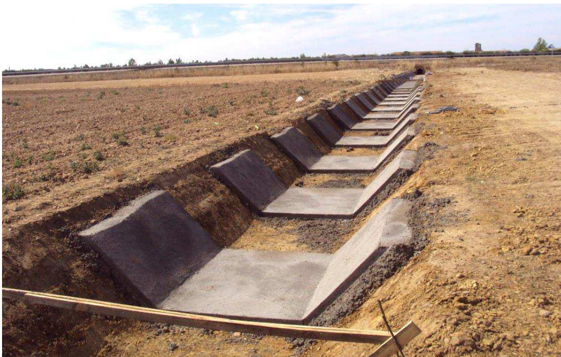
Obrázek 100: /ES/: Manuální realizace monolitického příkopu (zdroj: [60]).
