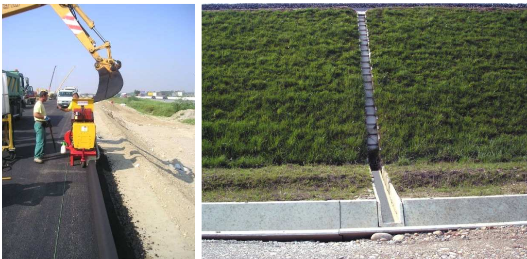
Obrázek 105: /IT/: Provádění asfaltové obruby na okraji pláně a kaskáda v místě přerušení obrubníku vyústěná do patního příkopu (zdroj: MASSENZA S.r.l.).
