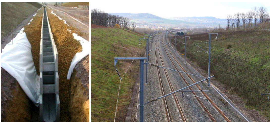
Obrázek 96: /FR/: Příkopový žlab z prefabrikátů a zářez odvodněný příkopovými žlaby (vlevo zdroj: SNCF[66]).
