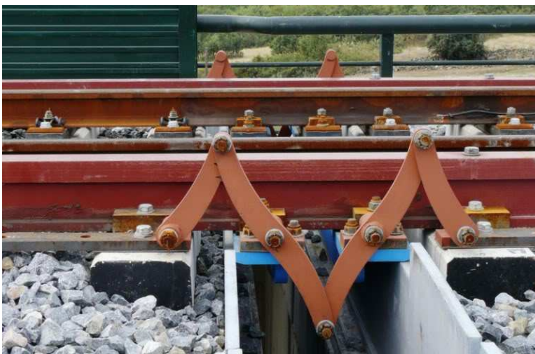
Obrázek 59: /ES/: Detail podepření kolejnic nad přerušeným kolejovým ložem (foto Alberto Salviejo).
