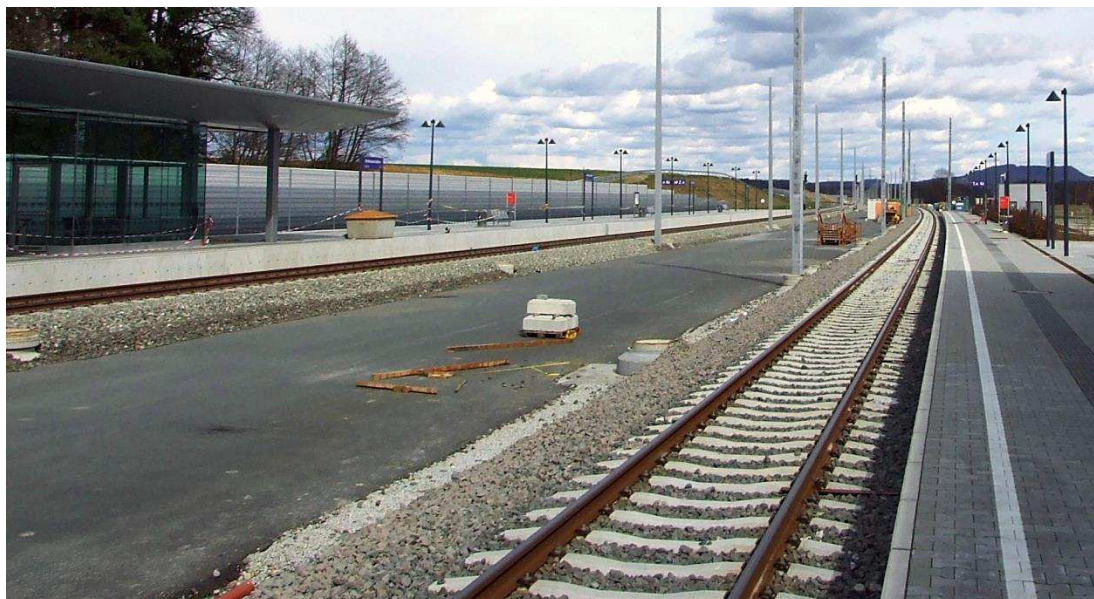
Obrázek 64: /AT/: Dokončená asfaltobetonová pláň tělesa pro průběžné koleje ve stanici Wettmannstäten (zdroj ÖBB).
